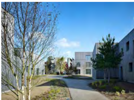
Projekt „Im Rebgarten“ in Riehen (CH)
