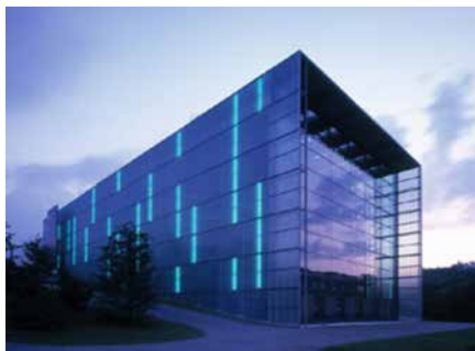
Hochregallager von ERCO in Lüdenscheid (DE)
